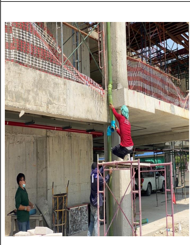
➤ ภาพถ่ายแสดงงานเดินท่อระบายน้ำฝน RL
