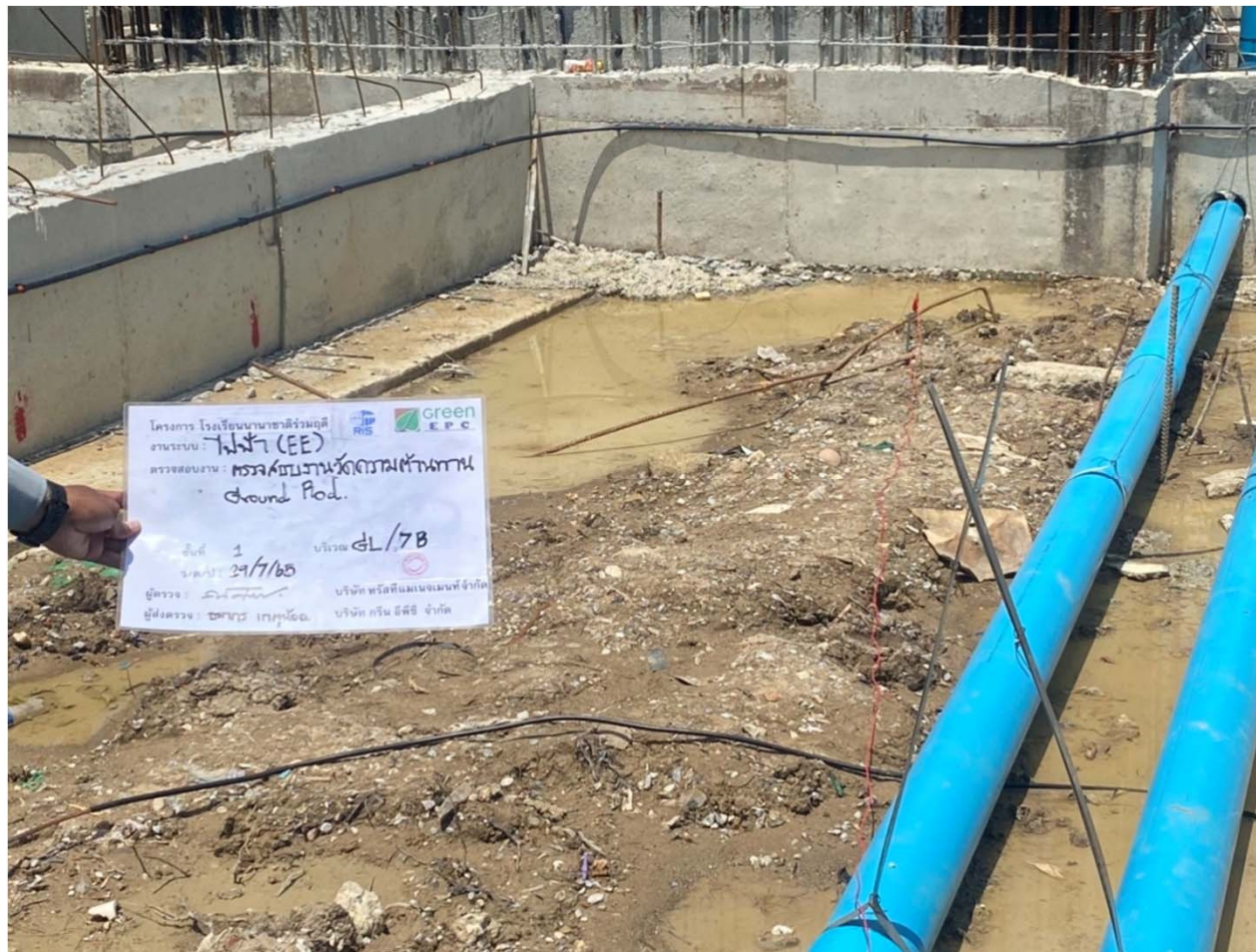
งานติดตั้ง Ground Rod Zone 2
