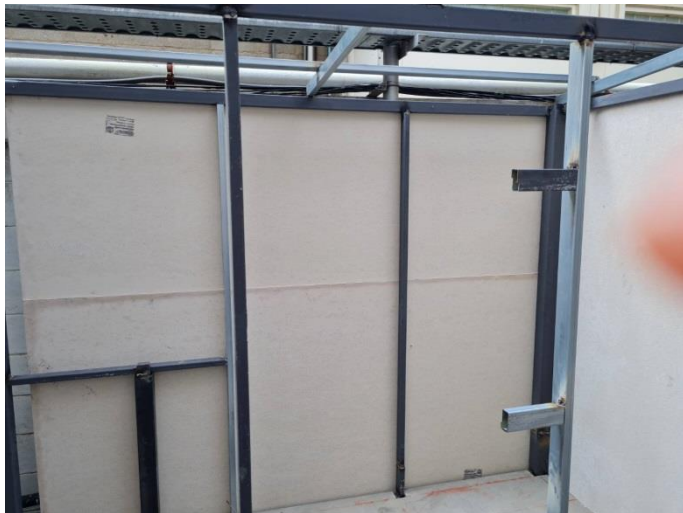
ติดตั้งห้องน้ำคนงานชั่วคราว
